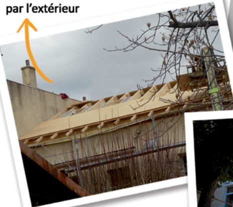
Isolation du toit par l'extérieur
