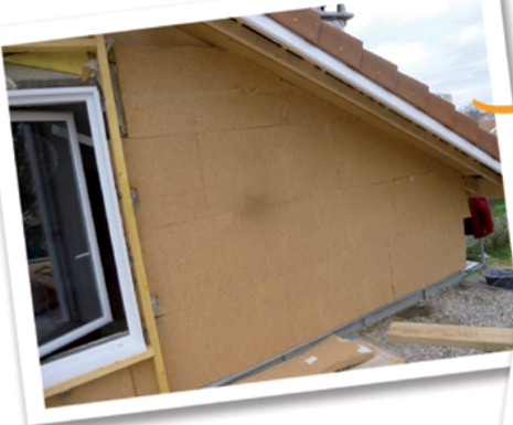
Test d'étanchéité à l'air
