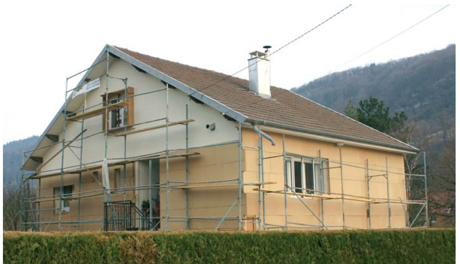
Rénovation d'une maison individuelle à Besançon (25)
