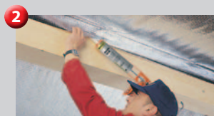
DELTA®-TIXX Colle en cartouche pour jonctions latérales (310 ml). Rendement : env. 7 m/cartouche
