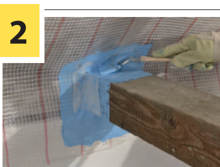
Rénovation en cours Pose du pare-vapeur DELTA®
