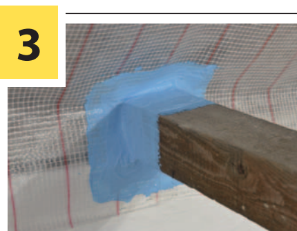
Après (pare-vapeur DELTA®-REFLEX, bande adhésive DELTA®-MULTI-BAND et étanchéité liquide DELTA®-LIQUIXX FX)
