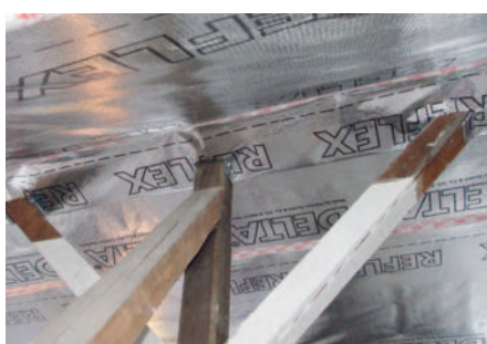
Rénovation en cours Pose du pare-vapeur DELTA®
