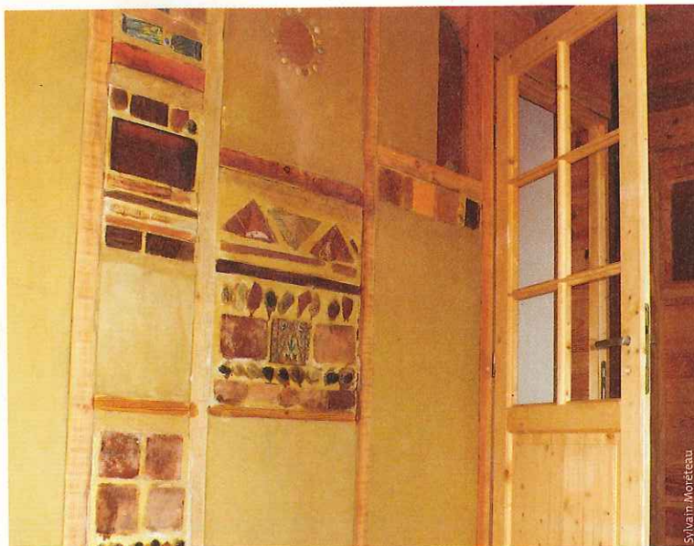
Les enduits terre sont appréciés pour l'inertie superficielle qu'ils apportent.
