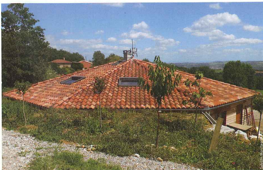
Les maisons semi enterrées profitent de l'inertie du sol, été comme hiver.
