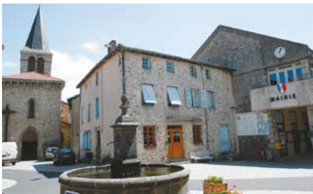
À Saint-Germain l'Herm (Puy-de-Dôme), le réseau de chaleur communal alimente des logements sociaux et des bâtiments publics et privés.
