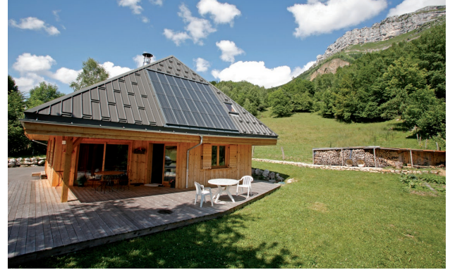
Un système solaire combiné (produisant à la fois le chauffage et l'eau chaude) est particulièrement bien adapté aux régions froides et ensoleillées où la période de chauffage est longue.
