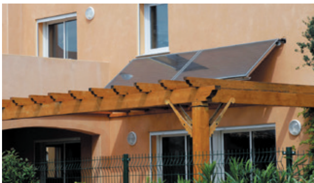
Une pergola est un exemple d'élément architectural qui contribue à protéger votre logement en cas de fortes chaleurs.
