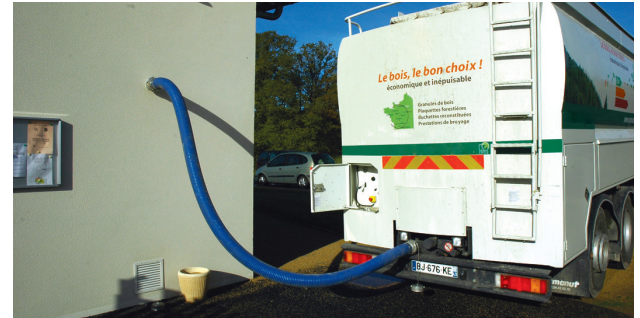
La livraison du granulé dans le silo de stockage se fait rapidement grâce à un camion souffleur.
