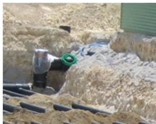
Montage de tubes et regards intermédiaires
