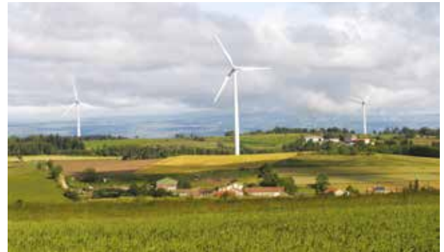
En 2014, en France, la production d'électricité éolienne a permis de couvrir 3,6% de la consommation annuelle.
